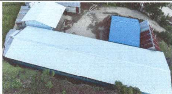
Foto 1: sustitución de láminas de todo el edificio escolar.
