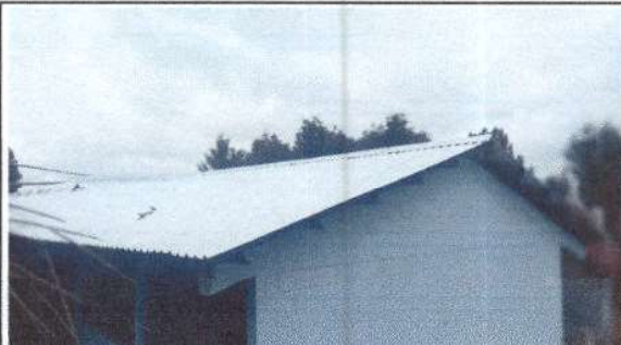
Foto 2: sustitución de láminas en la parte frontal.
